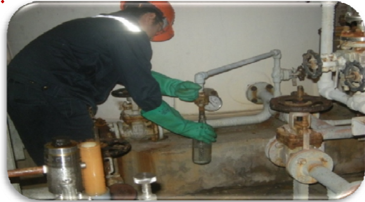
ขวดน้ำที่ 30 เก็บและตรวจสอบหน้างาน
